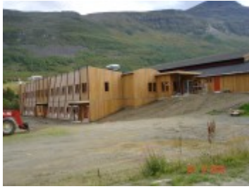
Sanitæranlegg Aja Samisk senter
